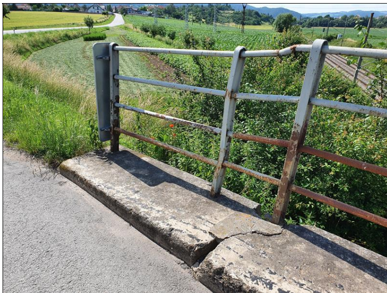
Poškozené zábradlí na křídle 1L
