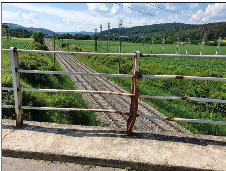
Poškozené zábradlí vlevo
